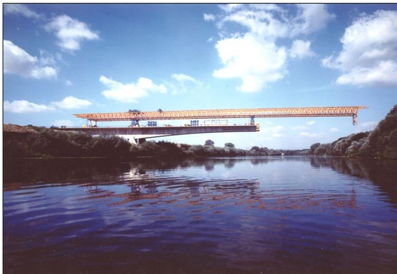
larghezza dell'impalcato è di 15.93m. L'impalcato è totalmente prefabbricato, con conci incollati per mezzo di resine epossidiche. I conci sono eseguiti a terra, la loro altezza varia dai 3 ai 7 metri e vengono montati con l'ausilio di un carro di varo. La precompressione longitudinale avviene con 90 cavi da 12 trefoli.
