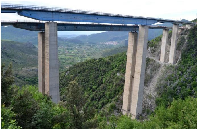
La tipologia strutturale dell'impalcato rispecchia uno schema Gerber con campata centrale e cantilevers in acciaio in lamiera irrigidita, mentre le due campate adiacenti sono realizzate con un sistema composto acciaio - c.a., ed il viadotto di accesso in c.a./c.a.p. L'intervento ha riguardato il ripristino di parti strutturali in cemento armato ed acciaio e la sostituzione di appoggi e giunti.
