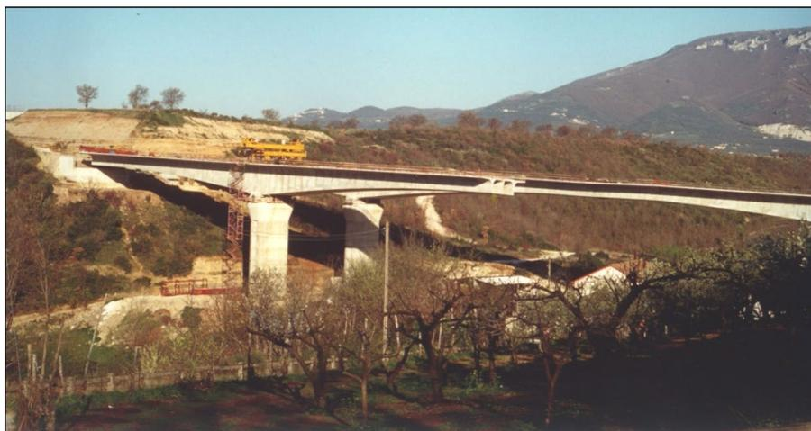
precompressione di conci gettati e maturati in uno stabilimento di prefabbricazione. La posa in opera avviene con l'ausilio di un carro di varo. Il viadotto da 100 m, a luce unica, prevede la presenza di due campate laterali di contrappeso.
